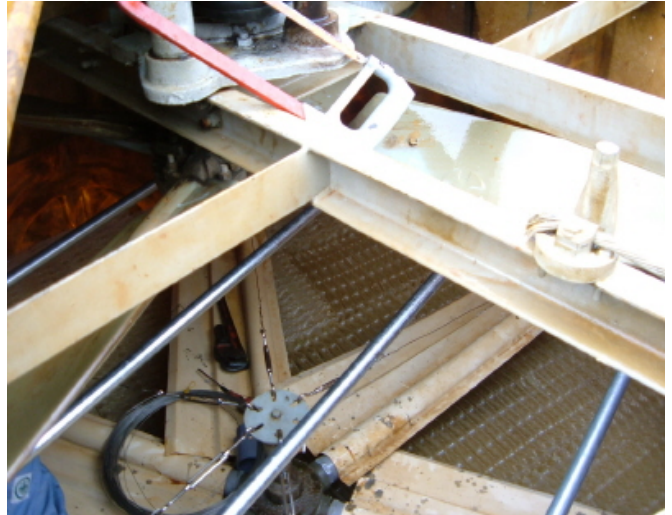
비산방지판 베이스 설치작업
